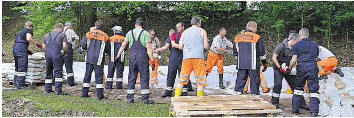
Aktive der Feuerwehr und Bauhofmitarbeiter sorgten für eine Stabilisierung des Damms.
