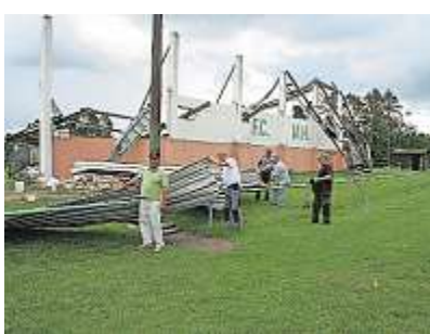
Der Sturm zerstörte den Tribünen-aufbau des FC.
