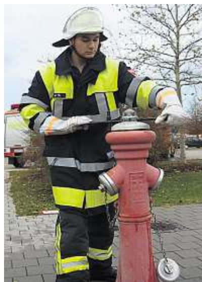
Geprüft wurde auch die Inbetriebnahme eines Hydranten.
